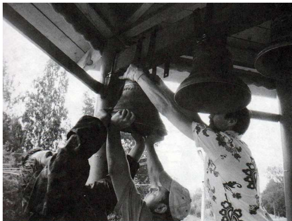
Установка колоколов на звоннице. 27 июля 2011 г.
