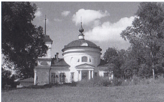
Покровская церковь в урочище Горошково в Сергиево-Посадском районе Московской области
